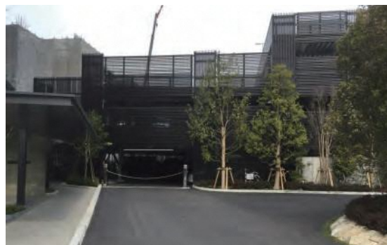
壁面をルーバーで修景し、前面を緑化した立体駐車場の事例
