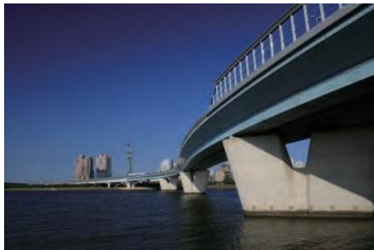
室見川にかかる都市高速道路
