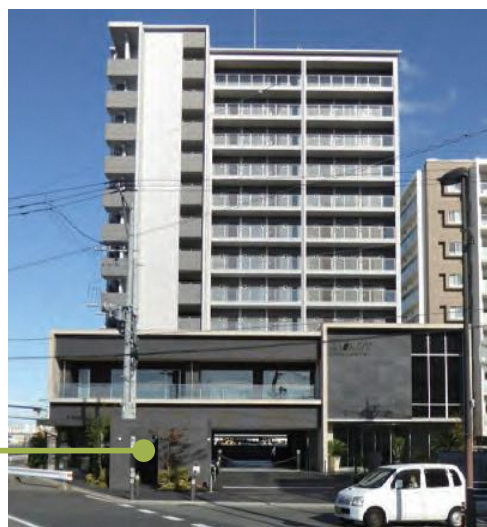
建築物と一体となったごみ置き場の事例
