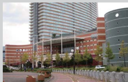
施設前の通りから
