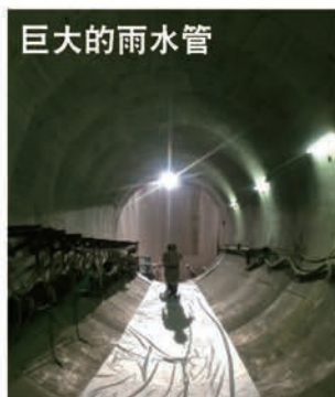
排出吸收的雨水
