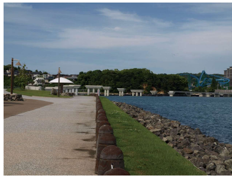
海上歩道橋(あいたか橋)の整備を契機に、ヒューマンスケールの魅力ある水辺空間が創出されています。
