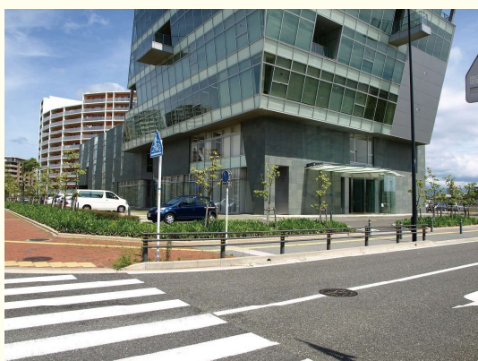
駐車場出入口を幹線道路以外の道路に配置し、また、公共空間から見えないうように境界部分を緑化など修景した事例
