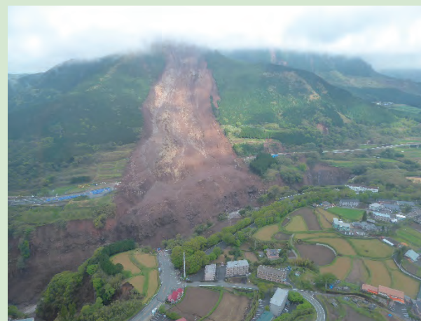
阿蘇大橋の崩落現場
