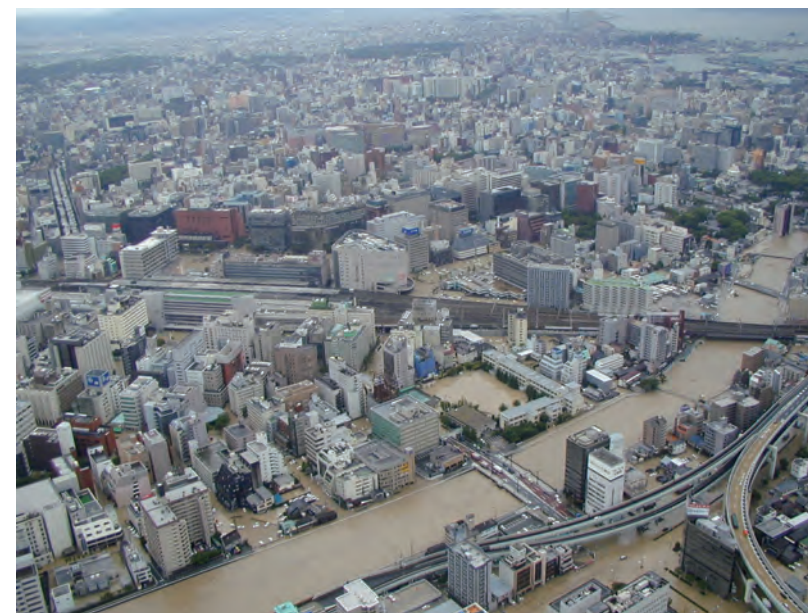
水浸しになった博多駅の周辺
