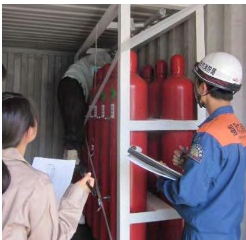
高圧ガスの輸入検査
