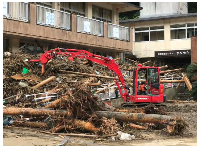
重機を活用した活動
