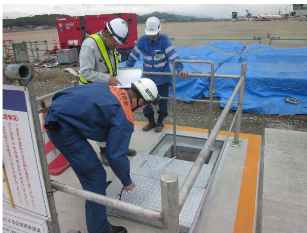
危険物施設の完成検査
