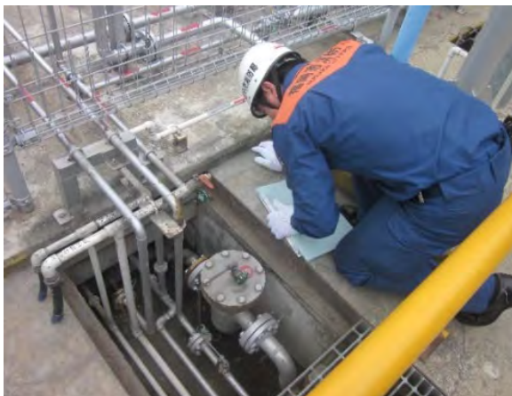
高圧ガス施設の完成検査
