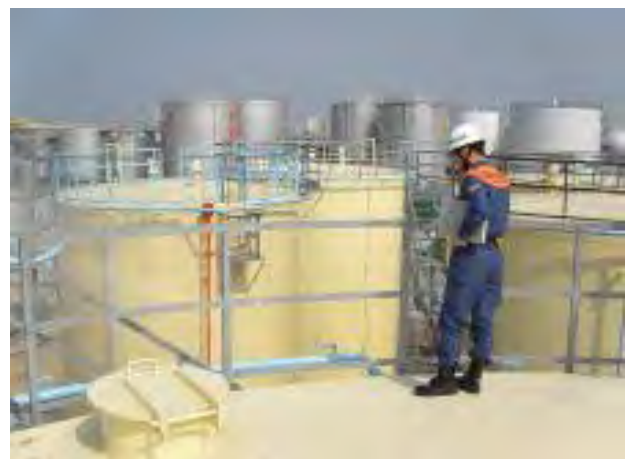
石油コンビナートの立入検査
