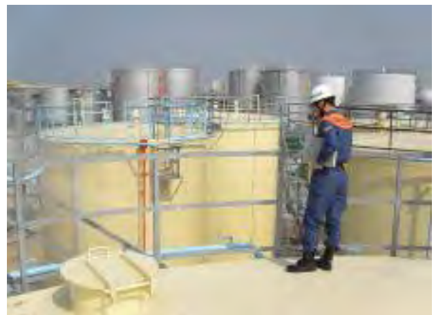
石油コンビナートの立入検査
