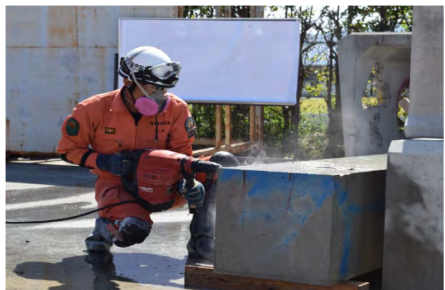
ハンマードリルを使用した破壊訓練
