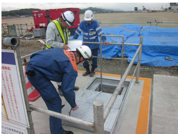
危険物施設の完成検査
