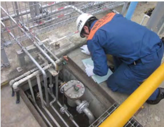
高圧ガス施設の完成検査
