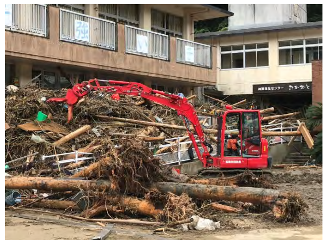
重機を活用した活動
