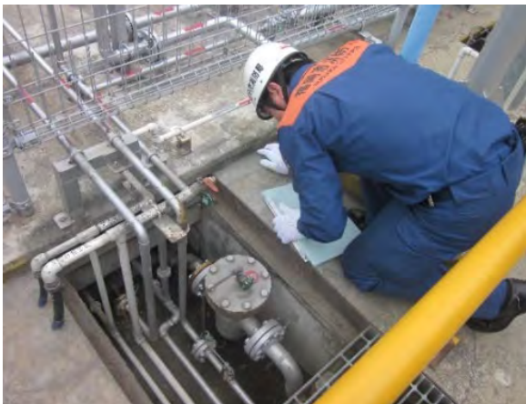
高圧ガス施設の完成検査
