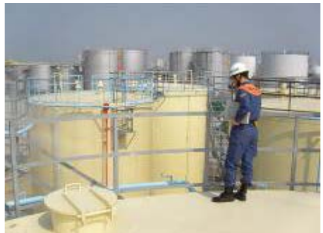
石油コンビナートの立入検査
