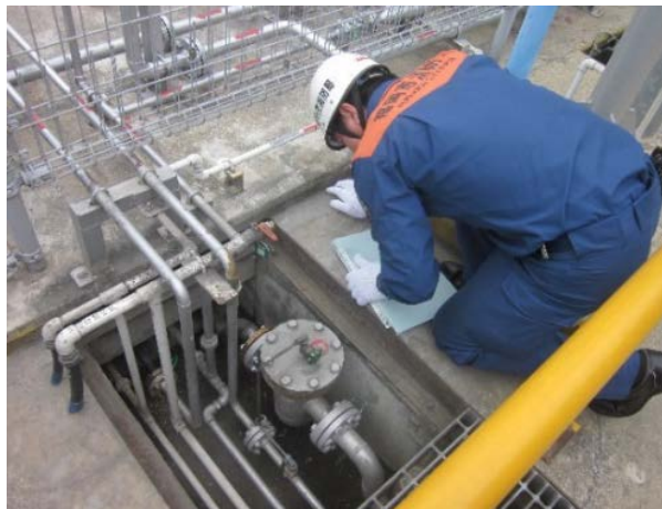
高圧ガス施設の完成検査
