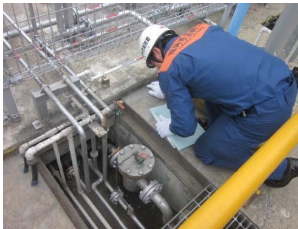
高圧ガス施設の完成検査
