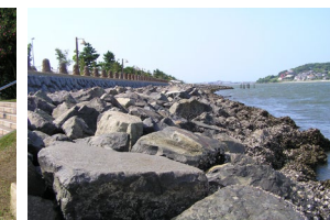
＜生きものの生息に配慮した護岸＞
