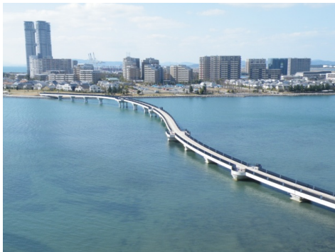
<海上遊歩道(あいたか橋)>
