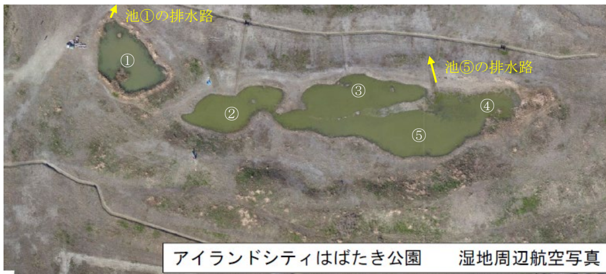
図 4 水位上昇時における池の湛水状況
