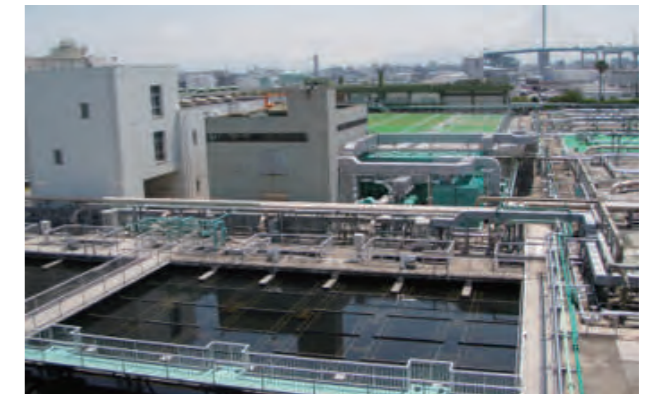
▲水処理センター
