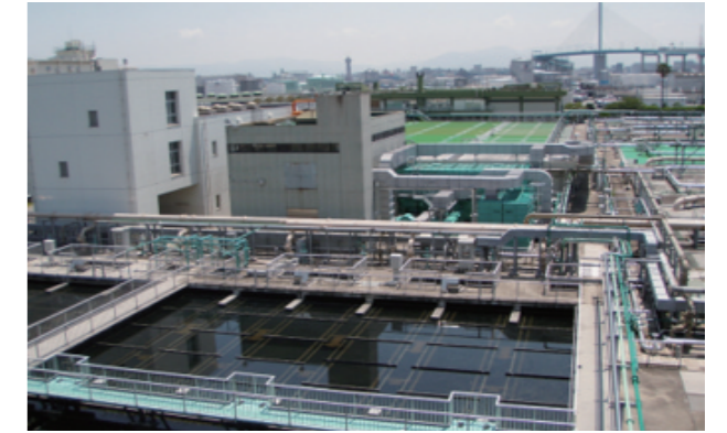
▲水処理センター
