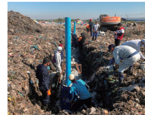
海外で福岡方式を利用して埋立場をつくる様子
