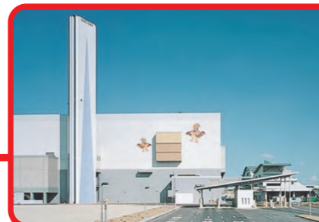
クリーンパーク・臨海 【福岡市東区箱崎ふ頭】 臨海工場 (平成13年3月完成) 1日に処理できるごみの量……900 t / 日
