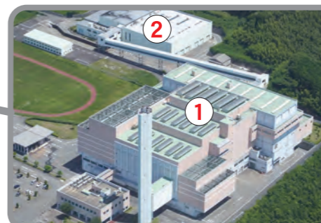
クリーンパーク・東部 【福岡市東区蒲田】 1 東部工場 (平成17年7月完成 (株)福岡クリーンエナジー建設運営) 1日に処理できるごみの量……900 t / 日 2 東部資源化センター (昭和61年9月完成) 1日に処理できるごみの量……175 t / 日
