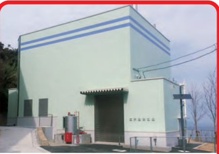
玄界島焼却場 (平成26年5月完成) 1日/8時間 処理できるごみの量……1t/8時間
