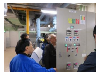
省エネ状況現地確認
