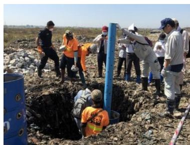
ヤンゴン市における「福岡方式」による埋立場整備
