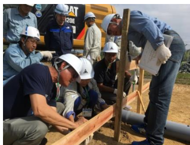
国内研修 (丁張の設置)
