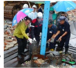
ガス抜き管設置のデモンストレーション (写真右)
