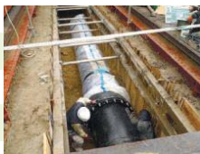
配水管取替工事の様子
