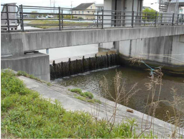
図8 昭代橋上流の堰
