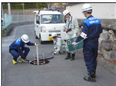
一次調査（市職員） マンホール蓋を開けての調査
