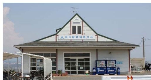
西戸崎旅客待合所 福岡県東区西戸崎1 丁目9 1-5 6
