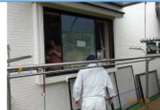
出窓取り換え中
