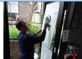
勝手口のガラス交換中
