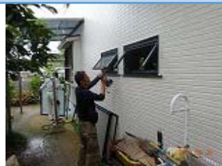
キッチンの窓ガラス交換中
