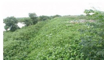
3.整備後の植生回復
