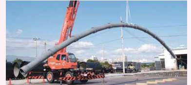
耐震管の吊上げ実験の様子 写真提供:一般社団法人日本ダクタイル鉄管協会
