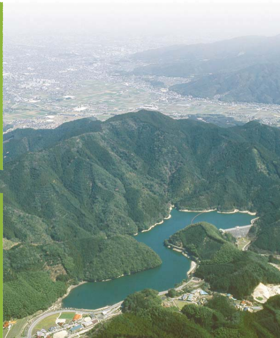
曲淵ダム上空からの写真
