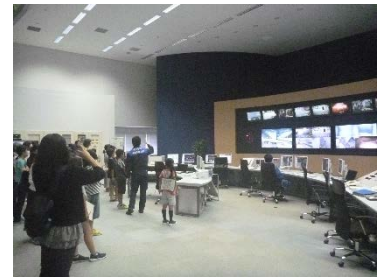
③中央制御室
