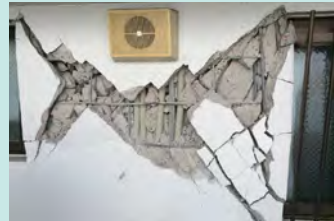
左上:建物外観 右上:高置水槽の転倒 左:雑壁のせん断亀裂
