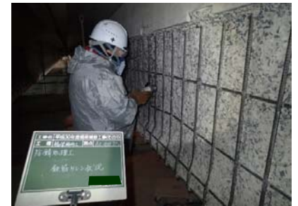
④【鉄筋の錆落とし】
