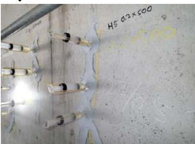
②【橋脚のひび割れ補修状況】
