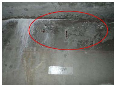
(1)【桁の鉄筋露出箇所】
