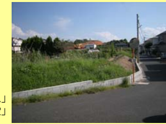
※工事中の「博多バイパス」 右が「香椎山の手建築協定」
