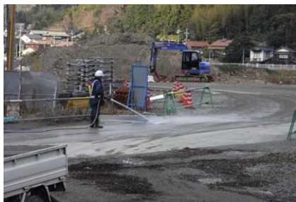
<工事施工ヤードへの散水>
