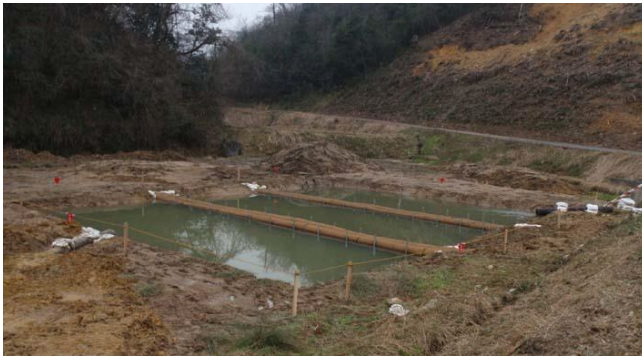
<仮設沈砂池の設置>
