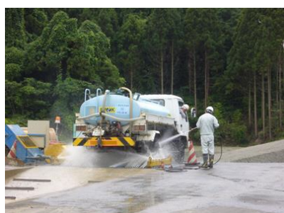
<工事用車両のタイヤ洗浄>
