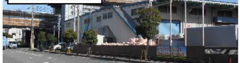
北西側から敷地を見る
