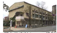
既存体育館(H28.11撮影)
