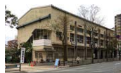
既存体育館(H28.11撮影)
