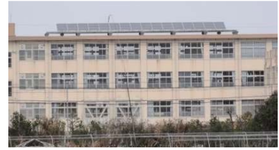
学校等の屋根貸し
