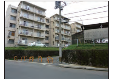
敷地段差部分の石積み
