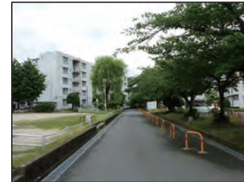
第1期工事エリア
