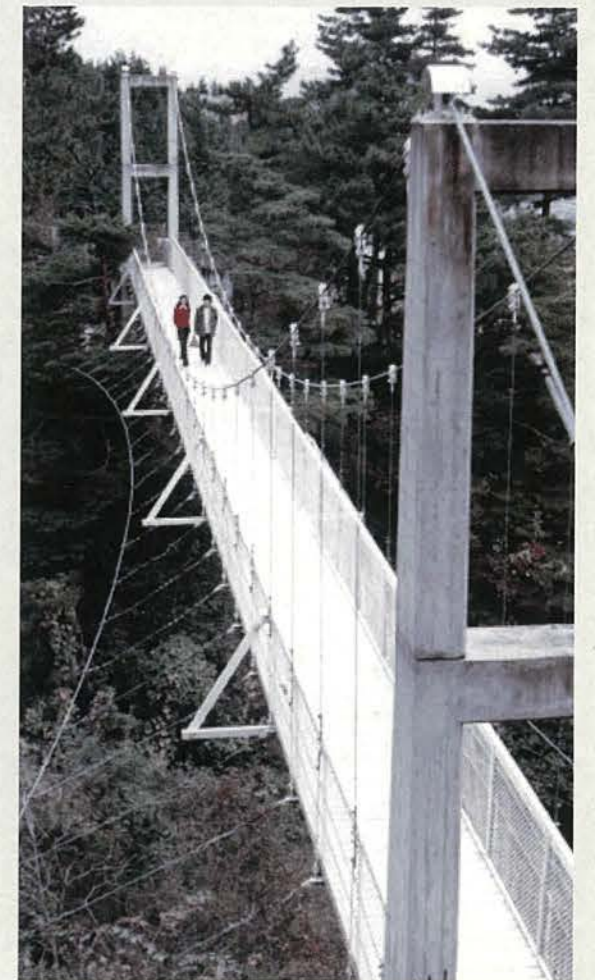
改修後の初代吊橋
