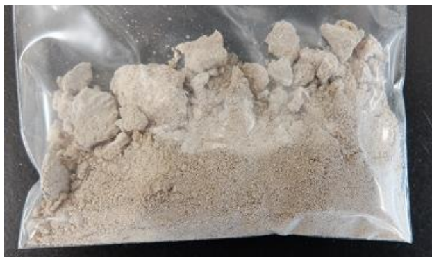
図 2 西部工場ボイラー水管付着飛灰
