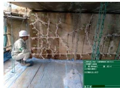
②【橋台のひび割れ補修状況】
