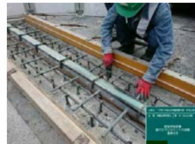
③【伸縮装置設置】
