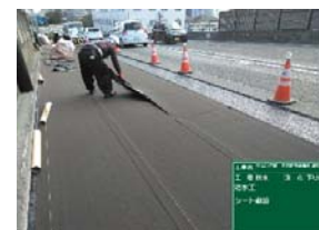
II【防水シート設置】
