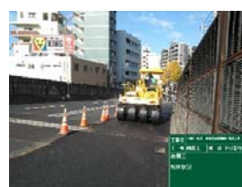
III【舗装打設】
