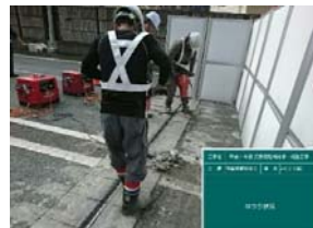
②【伸縮装置撤去】
