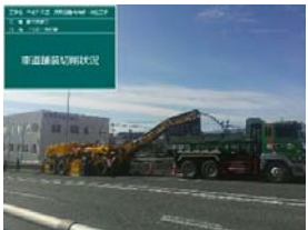
I【舗装撤去】
