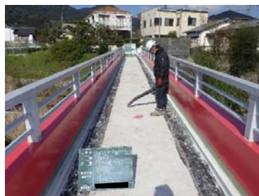
①【床版露出及び清掃】
