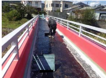
②【防水材塗布】
