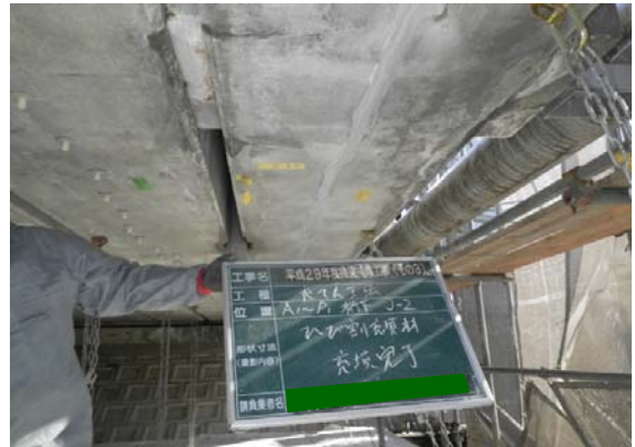
【修繕中】橋桁のひび割れ充填
