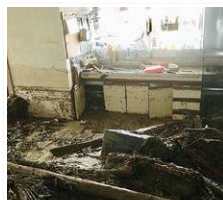
大量の泥や流木で埋めつくされた一階
