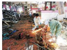
海岸沿いにあった観光物産館での、懸命な撤去作業
