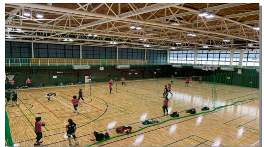
改修・再開館した「ももち体育館」
