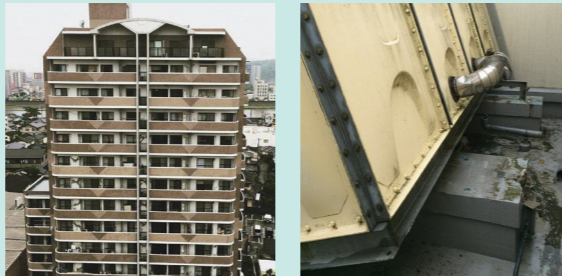
左上:建物外観 右上:高置水槽の転倒 左:雑壁のせん断亀裂
