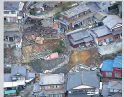
倒壊した住宅(福岡県西方沖地震)
