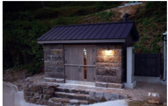
石積みの発電所建屋
