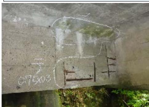
【橋桁の側面】うき、鉄筋露出
