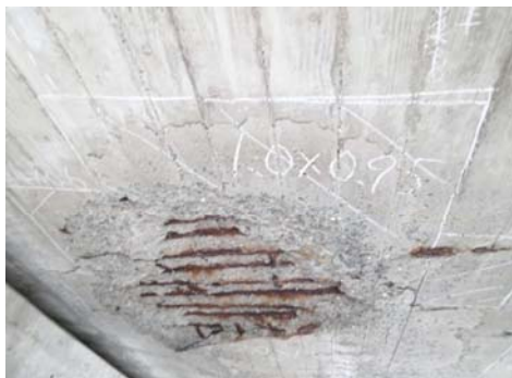
【橋桁の下面】うき、鉄筋露出
