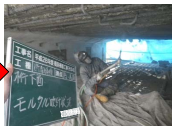
【橋桁の下面】うき、鉄筋露出
