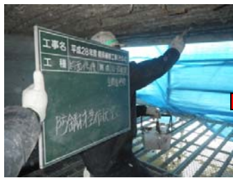
【橋桁の下面】うき、鉄筋露出
