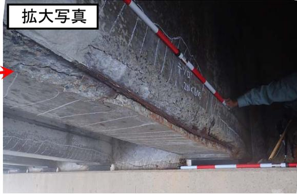
【橋桁の下面(西区側端部)】うき、鉄筋露出
